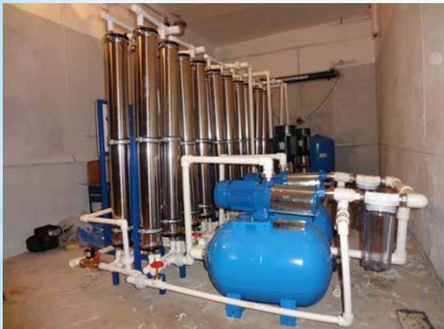
*Размещение обратноосмотической установки в помещении ФГУП «ЦЭНКИ» – КБ «Мотор», 6 м<sup>3</sup>/час*
