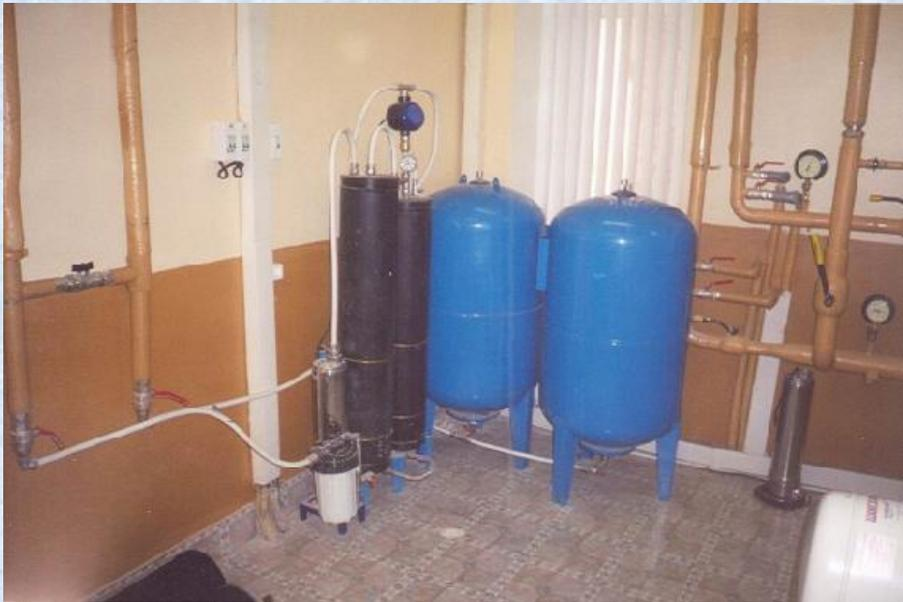
Водоподготовка для подпитки системы отопления, 2 м куб/ч
