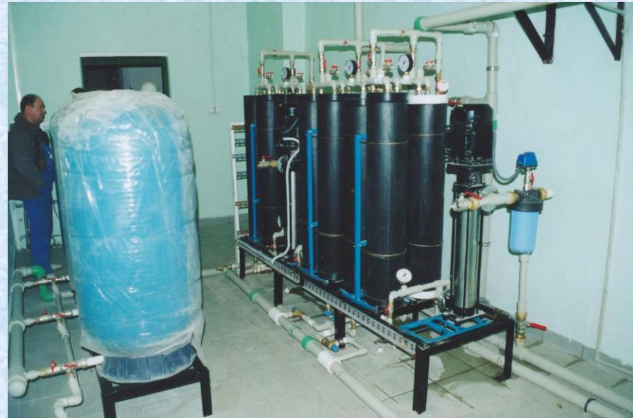
Улучшение качества водопроводной воды для офисного здания, 20 м куб/ч
