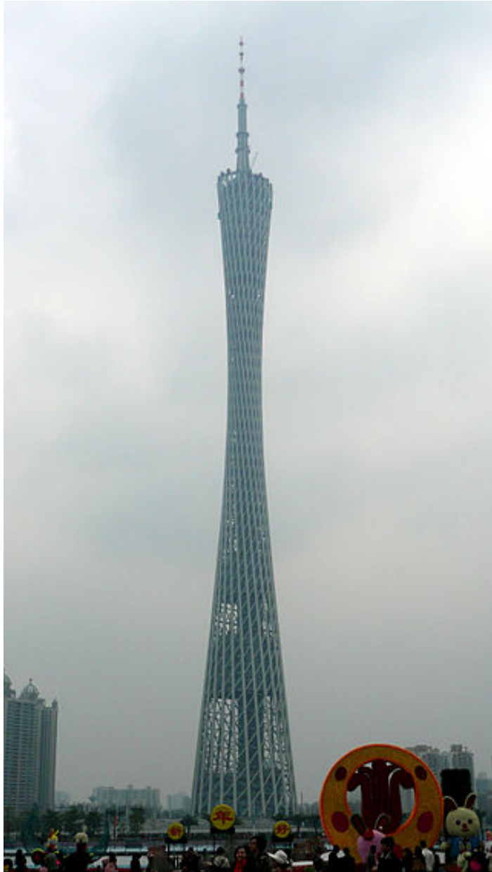
Башня Гуанджоу (Китай), 2005-2010
